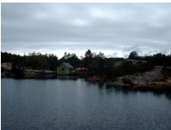
Inntakshuset i Kjerketjødne. Foto: Per Einar Lædre
