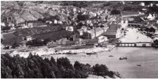
Gruset under utfylling, ca 1920. Foto: T. Sandstøl/DF
