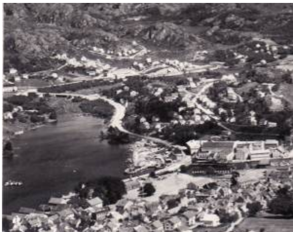
Jernbaneveien under bygging i 1956. Foto: Widerøe/DF (Utsnitt)
